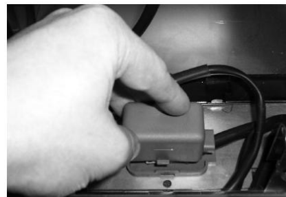
Rys. 26 ...założyć i zapiąć skrzynkę połączeń...
